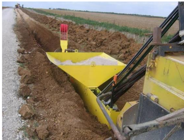
Figure 11: Exemple de trancheuse et dépose du câble
